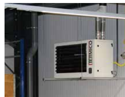
Dans la partie dédiée au stockage, il était plus indiqué pour des raisons de sécurité de placer des aérothermes et des déstratificateurs de Termico.
