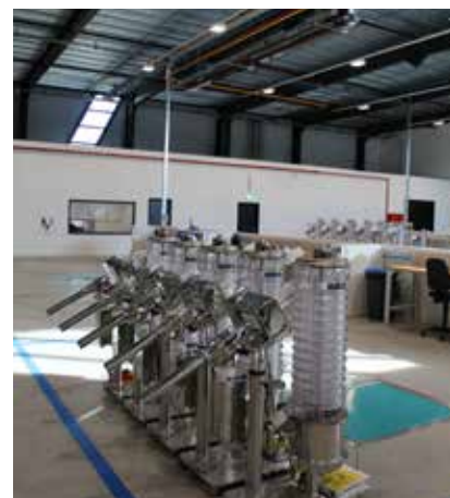
On a placé des tubes radiants de Termico au-dessus de chaque poste de fabrication de dépoussiéresseurs.
